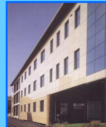
Edificio industriale, IMOLA
