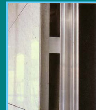
Struttura messa in opera
