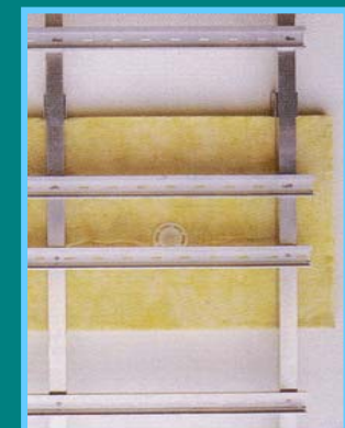
Struttura con pannello isolante
